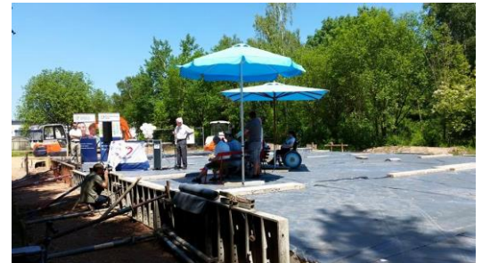
Die Arbeiten am Bau für schwerstmehrfachbehinderte Bewohner in Altendorf beginnen.
